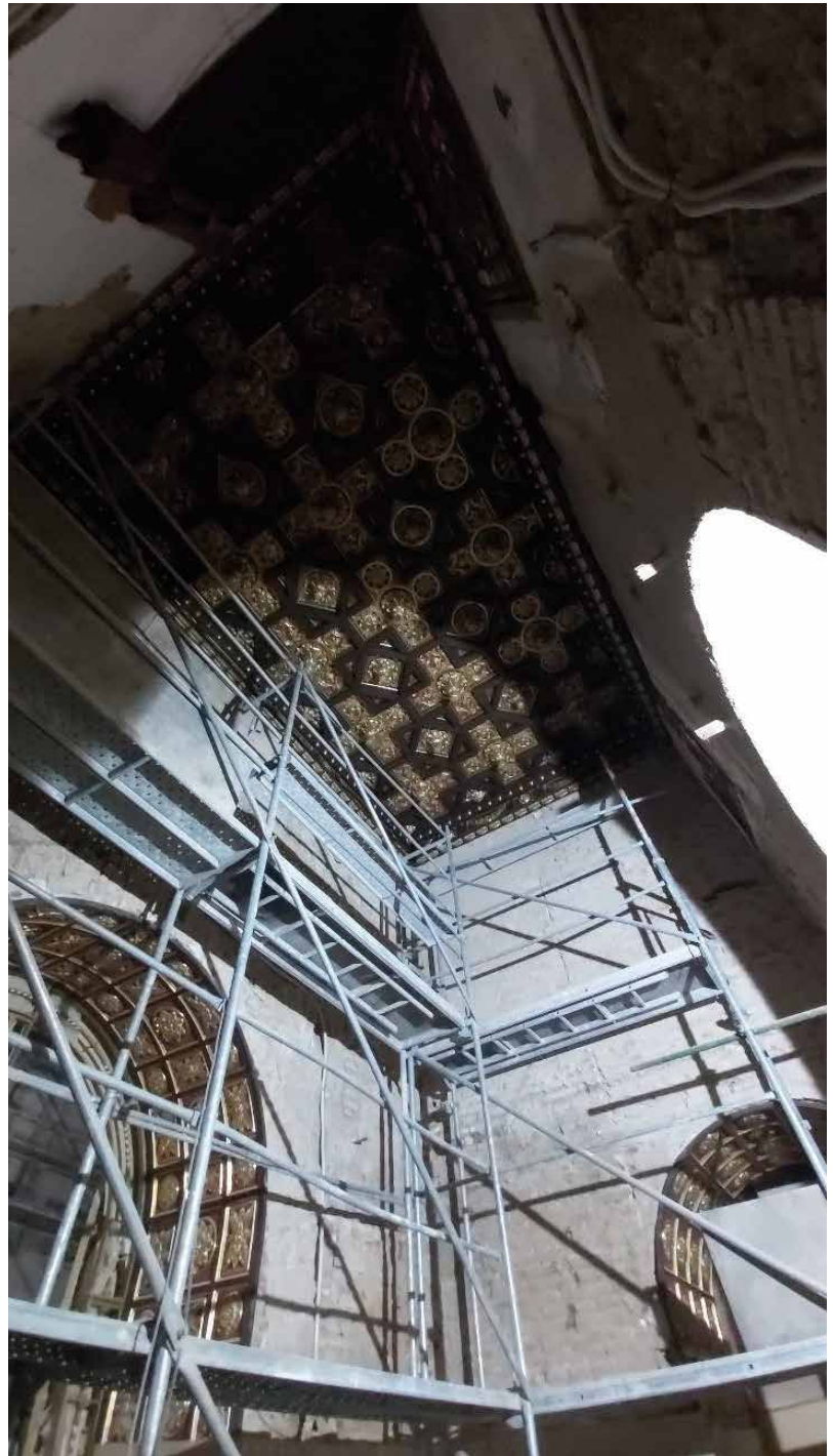
Trabajos de desmontajes y restauración de paramentos en la Capilla de la Hermandad de la Soledad (Foto: J2 Edificación y Desarrollo)
