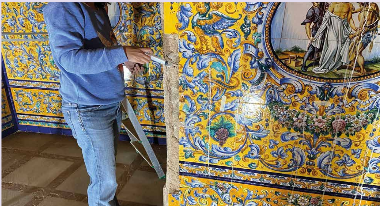
Trabajos de restauración del zócalo de azulejos (Foto: J2 Edificación y Desarrollo)
