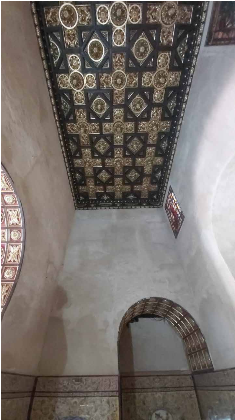
Trabajos de restauración de paramentos en la Capilla de la Soledad (Foto: J2 Edificación y Desarrollo)
