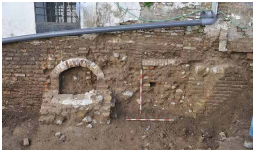
Criptas. A la izquierda se observa la cripta que va a ser integrada en el columbario.
