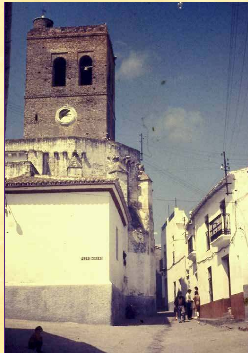
▲ La Torre vista desde la que se llamara entonces calle Carlos Mendoza (que después fuera calle Antonio Machado y ahora de la Virgen de la Esperanza). El reloj aparece roto en esos momentos, y la Torre evidencia la necesidad de restauración, que no se produjo hasta iniciado este siglo XXI.
