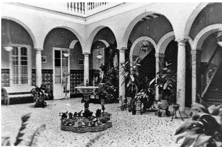
Fotos del patio interior de la Casa-Palacio de Seoane en El Puerto
