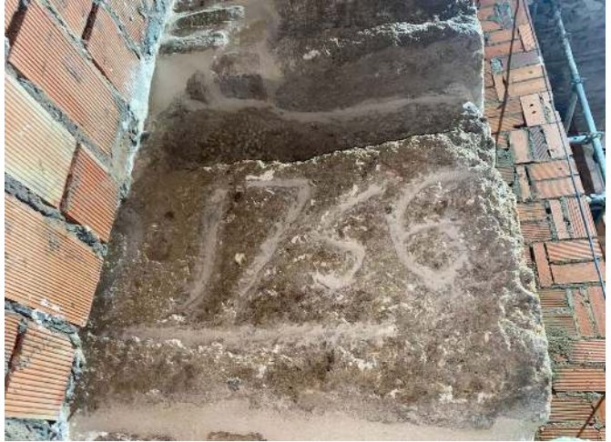
Marca de cantero tallada en uno de los sillares que cierran el presbiterio de la capilla de San Gregorio.
